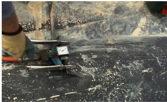
Photo 21 : Contrôle de la pression du canal de la double soudure
