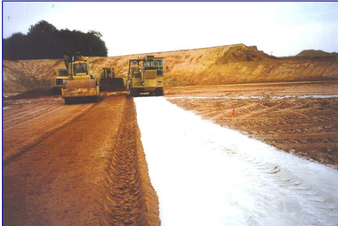
Mise en place de matériaux rapportés et de la bentonite
