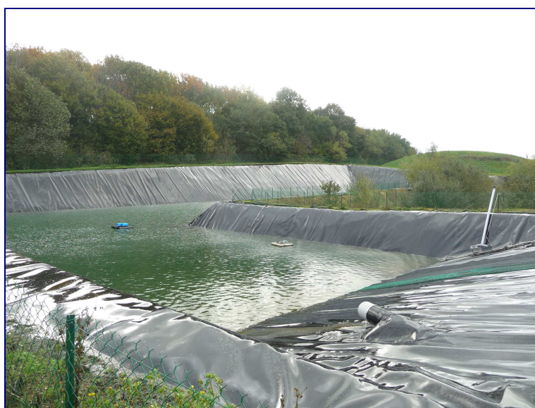
Photo 8 : Bassin de rétention des eaux
