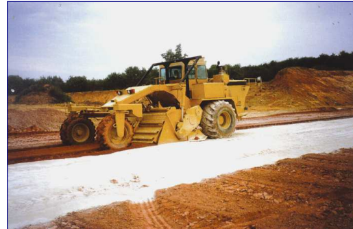
Compactage de la couche de mélange
