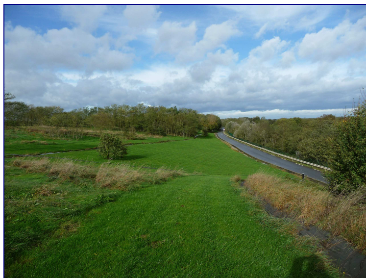
Photo 17 : Zones réaménagées de l'ISDND actuelle
