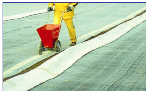
Assemblage des GSB par ajout de bentonite en vrac
