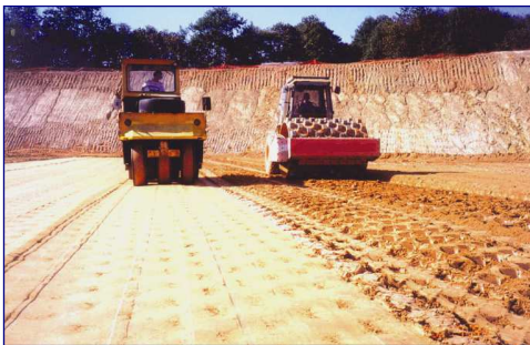
Mélange de la couche de matériaux rapportés et de la bentonite
