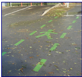
Photo 12 : Marquage au sol pour piéton
