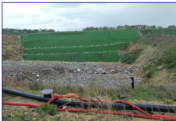
Photo 3 : Zone en cours d'exploitation
