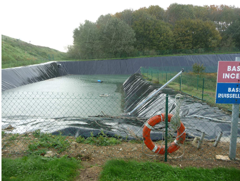
Photo 20 : Bassin de stockage d'eaux de ruissellement
