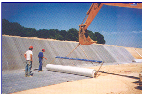
Pose des rouleaux de GSB en tuile
