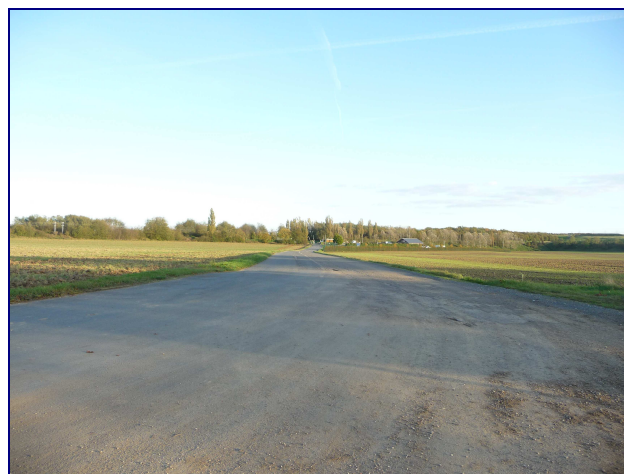
Photo 9 : Voie d'accès à l'installation
