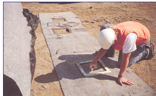
Test de contrôle in situ de la qualité du Géosynthétique Bentonitique
