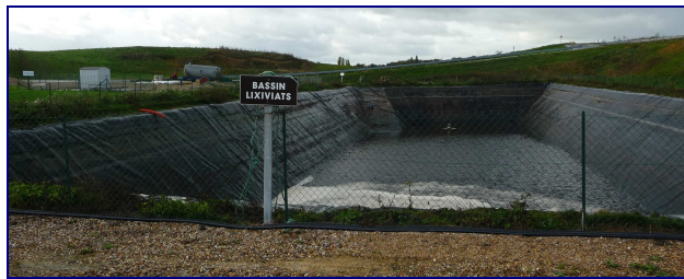
Photo 22 : Clôture d'un bassin de stockage des lixiviats
