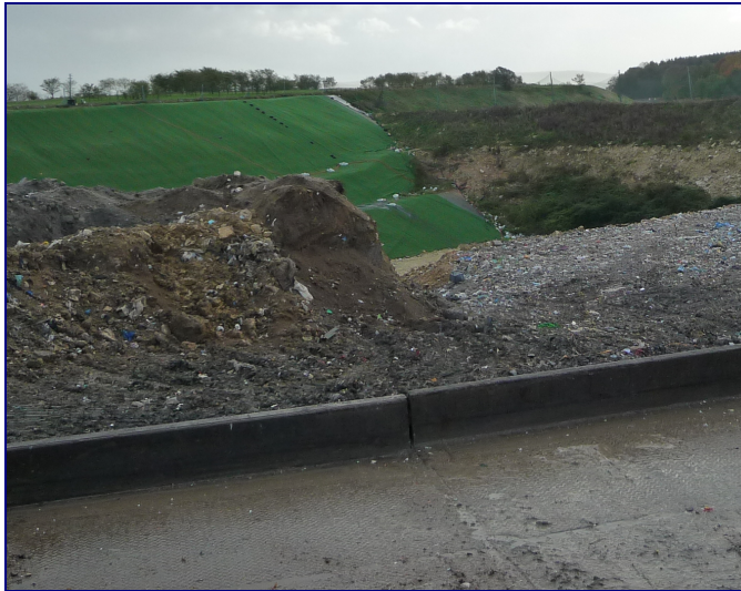
Photo 15 : Blocs roues situés au niveau du quai de déchargement
