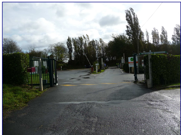
Photo 17 : Voie de circulation et pont-bascule au niveau de la zone d'entrée
