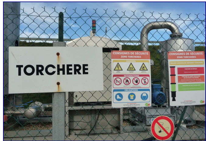
Photo 12 : Consignes de sécurité affichées au niveau de la zone de traitement du biogaz
