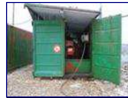
Photo 13 : Zone de maintenance des engins
