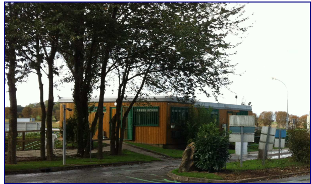
Photo 28 : Bâtiment administratif du site
