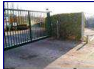
Photo 27 : Portail du site fermé en dehors des heures d'ouverture
