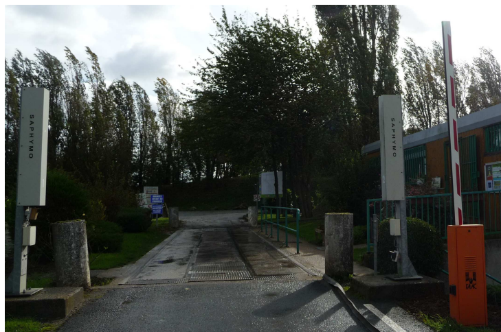
Photo 9 : Portique de radioactivité au niveau du pont-bascule
