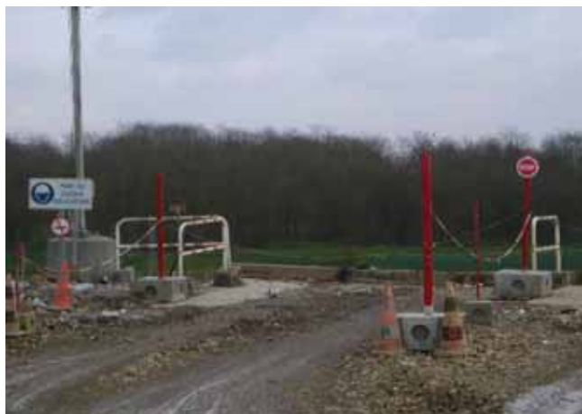
Quai de déchargement
