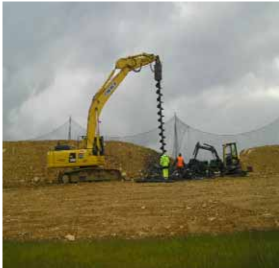
1) Forage d'un puit
